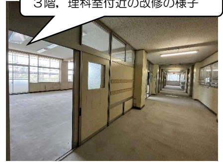
3階， 理科室付近の改修の様子
