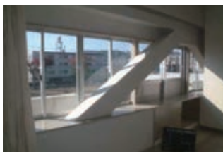
耐震補強された教室
