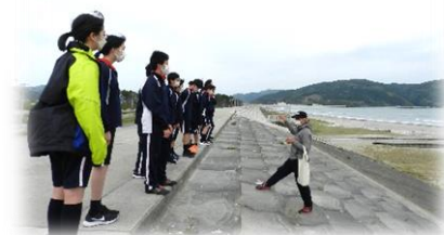
門脇中近くの防潮堤にて
