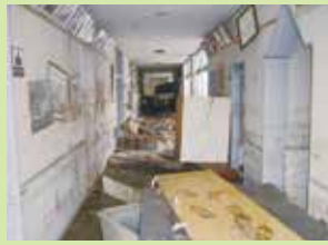
被害を受けた東六郷小の校舎内
