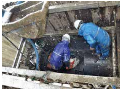
他県からのガス・水道復旧工事支援
