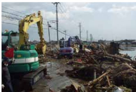
震災直後、自衛隊や警察・消防隊が進めるように道路を広げる建設業の方々
