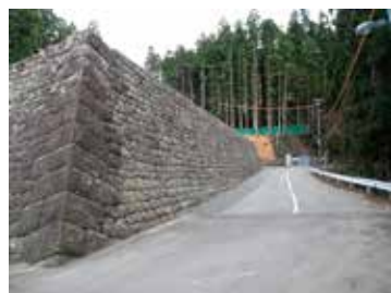
復旧工事終了後(平成27年2月)
