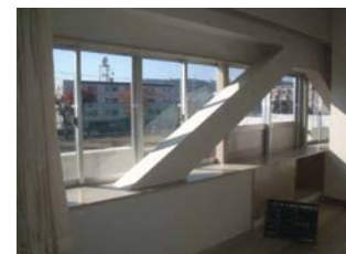
耐震補強された教室
