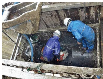
他県からのガス・水道復旧工事支援
