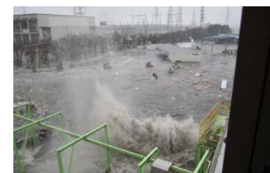
中野雨水ポンプ場をおそった津波
