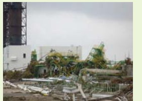
仙台市南蒲生浄化センター
